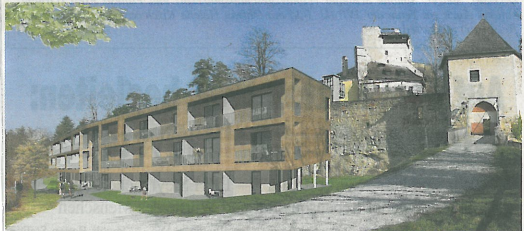
Die neue Jugendherberge wird über 90 Betten in 26 Zimmern vorfließen
